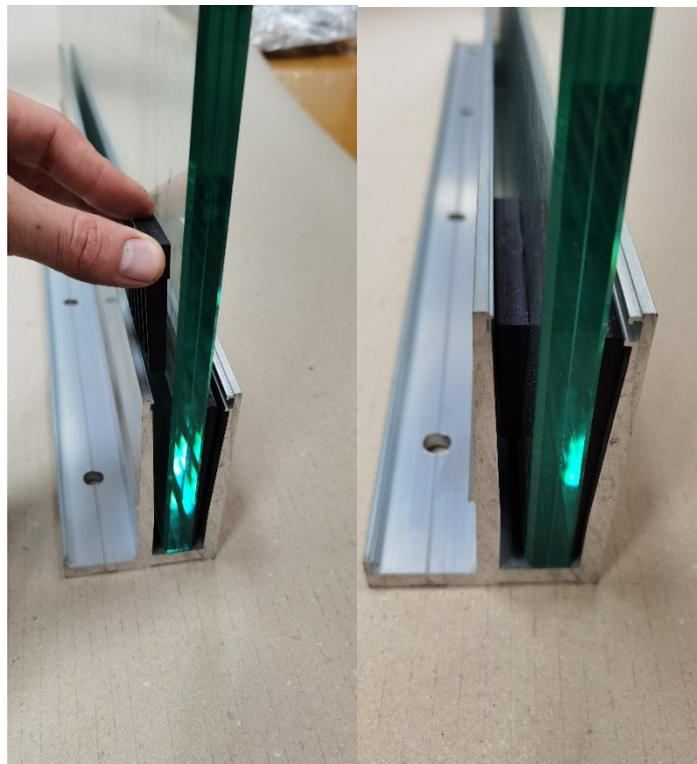
8. Placez le caoutchouc intérieur, qui vient sous pression avec vos doigts, et placez le profil dans la zone des vis pour avoir la finition finale.
