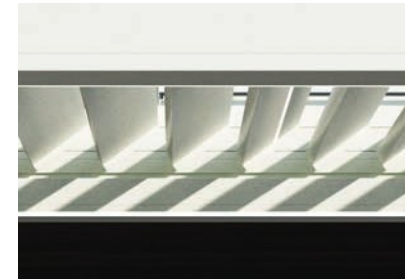
Contrôle solaire grâce aux lames orientables
